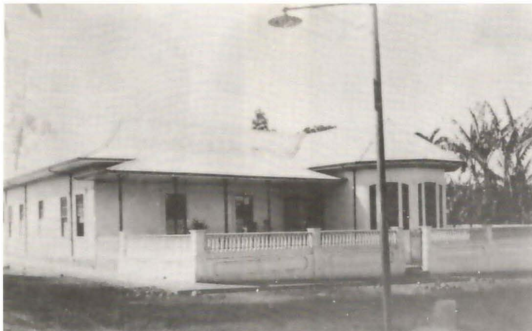
Casa de habitación que prestaba servicios como la Unidad Sanitaria y que sirvió como Maternidad y primeros auxilios a la comunidad, mientras se construía el nuevo hospital de Grecia. (Hoy día es la casa de habitación del señor Jorge Enrique Hidalgo Pacheco y familia, 100 mts. Sur Casa Cural).
