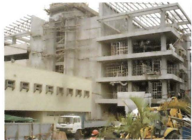
Construcción del Edificio de Especialidades
