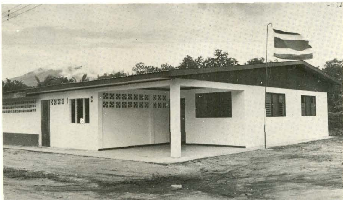
Clínica de la Consulta Externa de La Fortuna de Bagaces. Se construyó con fondos provenientes de la propia comunidad.
