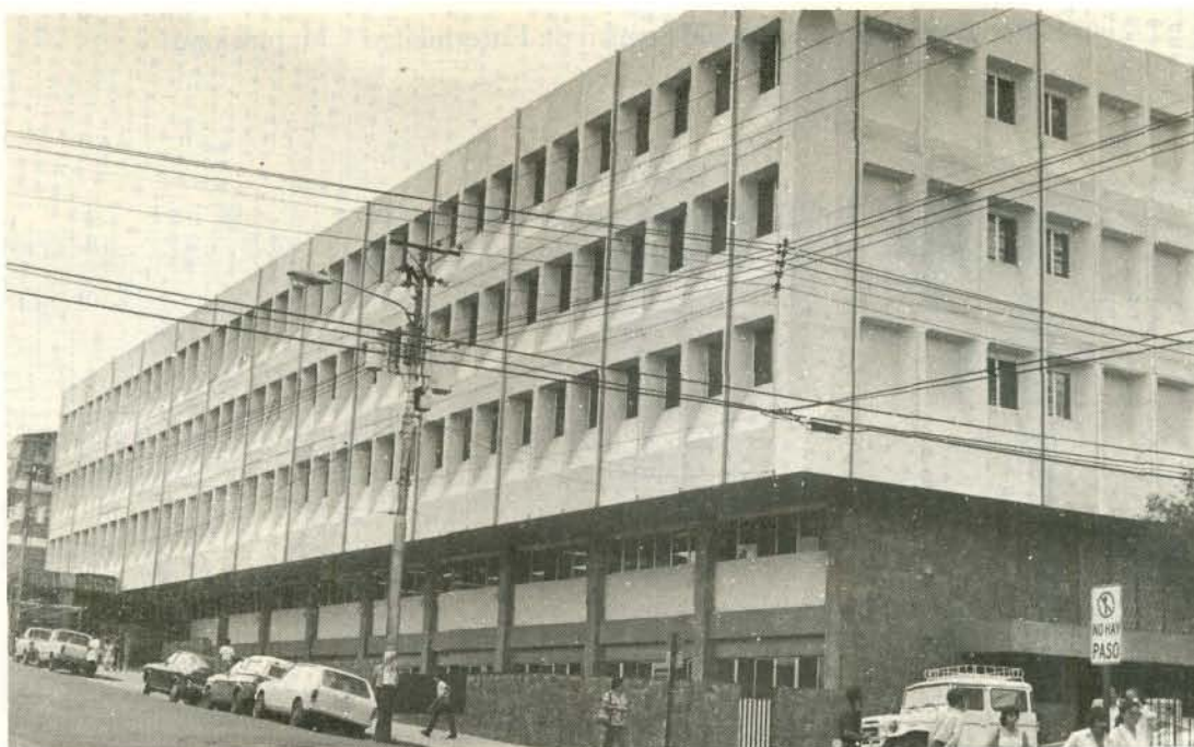
Vista del edificio anexo del Hospital Dr. Calderón Guardia.
