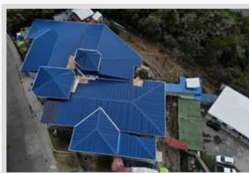
Remodelación de Cambio de techo de Sub Sede Monteverde.
