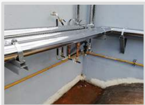
Sustitución de tuberías de agua caliente y vapor Hospital Max Terán Vals.
