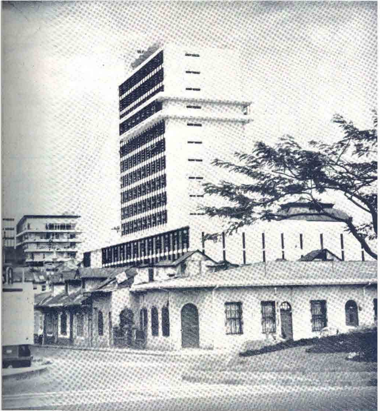
Otra Vista del nuevo Edificio Central de la Caja
