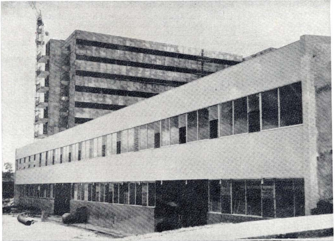
Casa de Máquinas del Hospital México. Al fondo se ve la estructura del nuevo Hospital.
