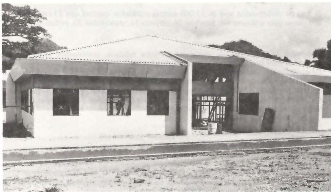
Clínica Colonia Carmona. Costo: ₡ 1.800.000,00 – área: 825 metros cuadrados – consultorios: 7 – fecha de terminación: 22-5-78.
