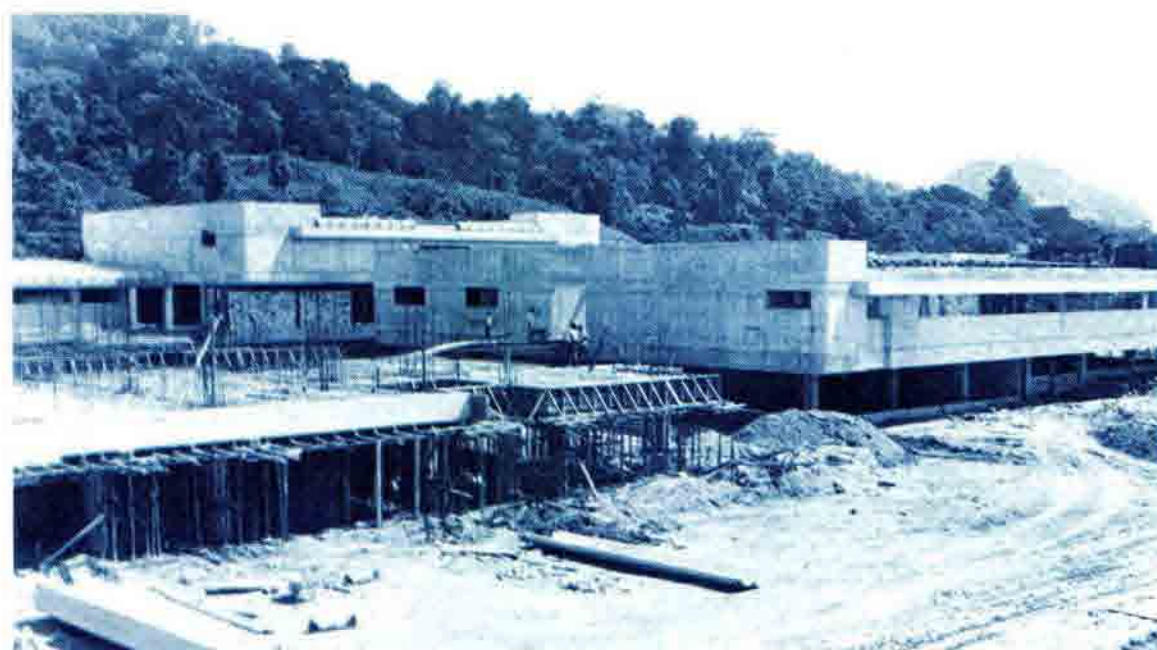
Hospital de Ciudad Neilly, obra en proceso de construcción A concluirse el 13-10-80
