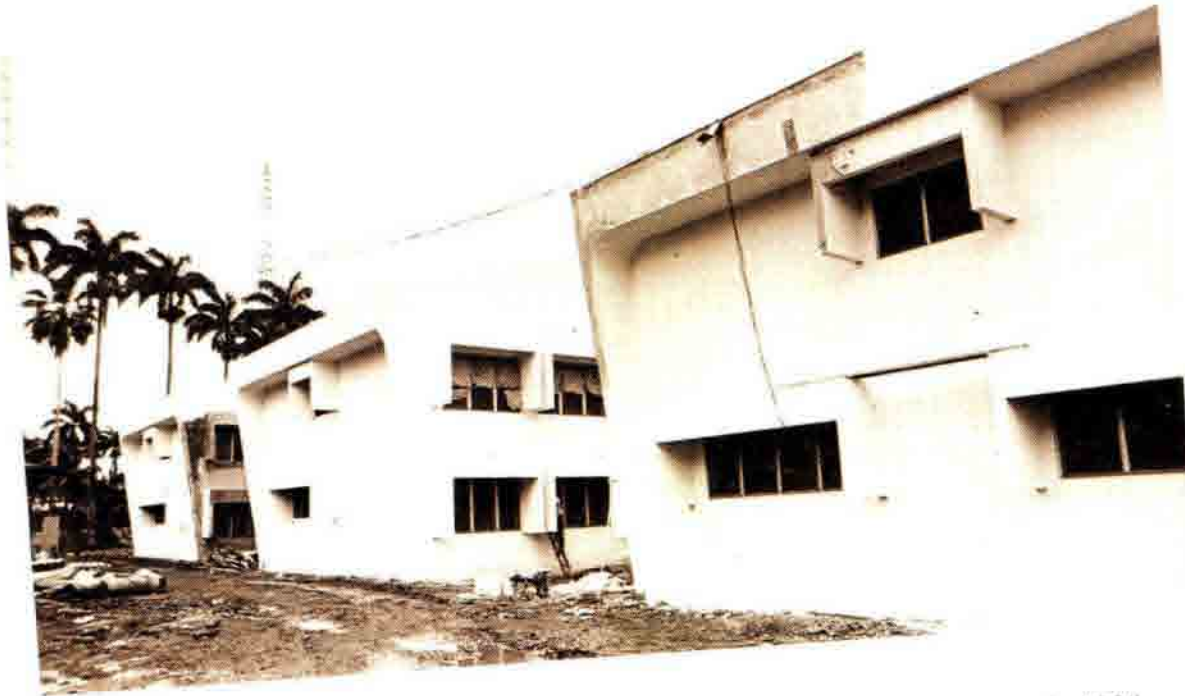
Avance de las obras del Hospital de Limón, a concluir el 16 de noviembre de 1980
