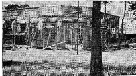
Vista exterior del edificio en construcción
