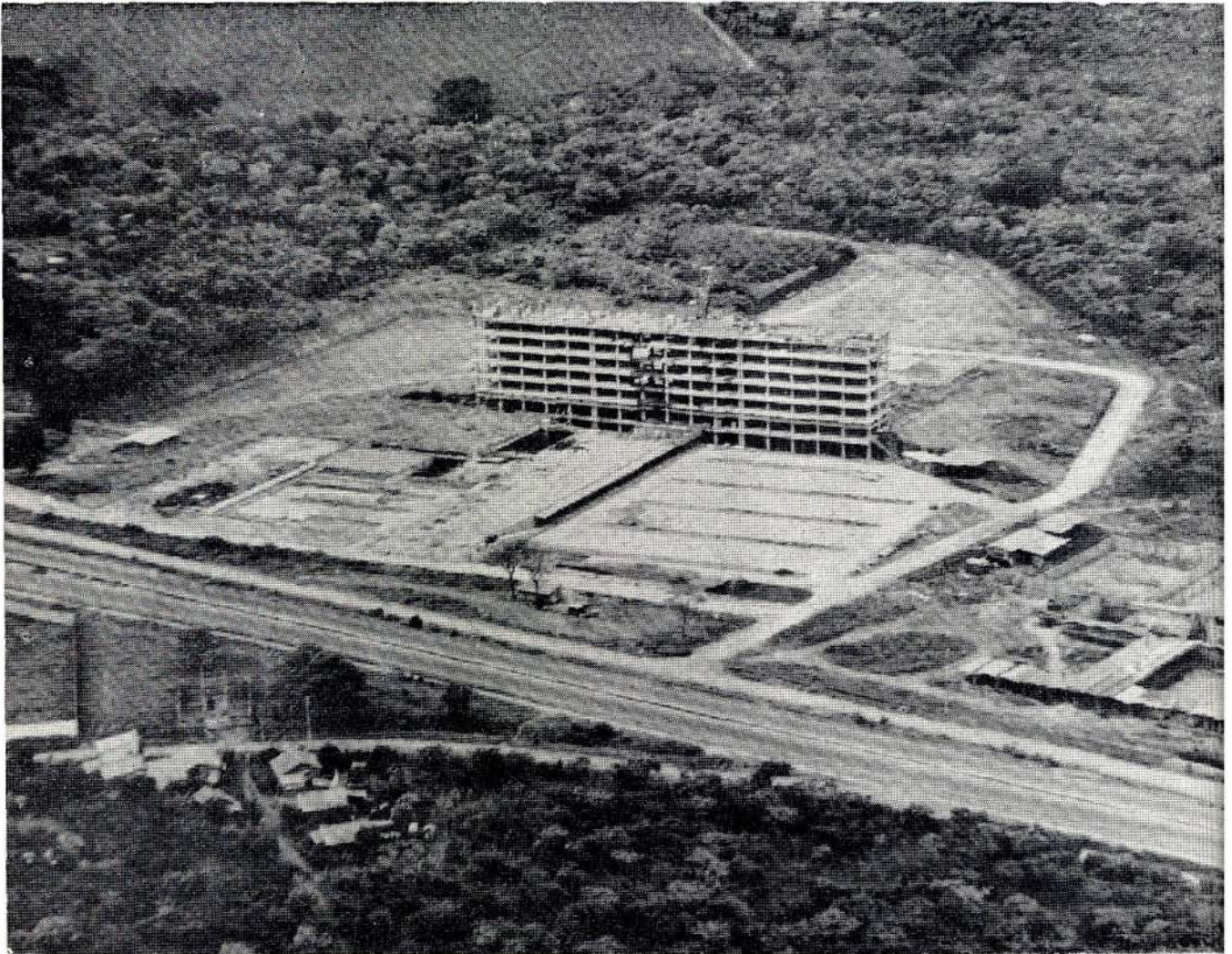
Vista aérea del Hospital México en construcción.
