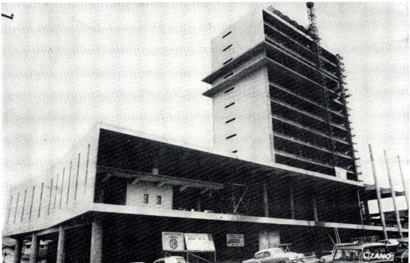
Vista de la estructura del nuevo Edificio Central de la Caja que se está construyendo
