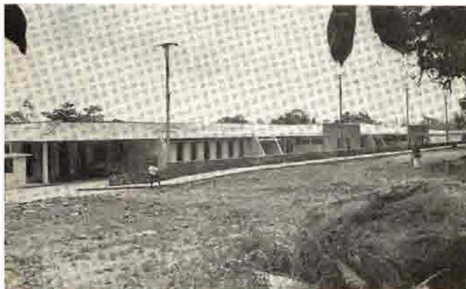
Hospital de Guápiles. Tiene una área de 6.500 m 2 , con capacidad para 72 camas. A diciembre de 1972 muestra un avance del 95%, con una inversión de ₡4.982.544.00
