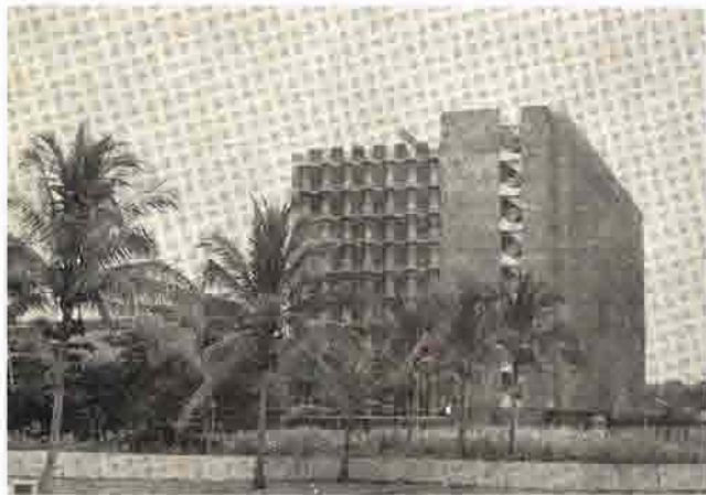
Hospital Monseñor Sanabria, ubicado en la Provincia de Cartago. Tiene una área de 18.000 m 2 con una capacidad para 400 camas. Su costo fue de ₡33.962.765.00
