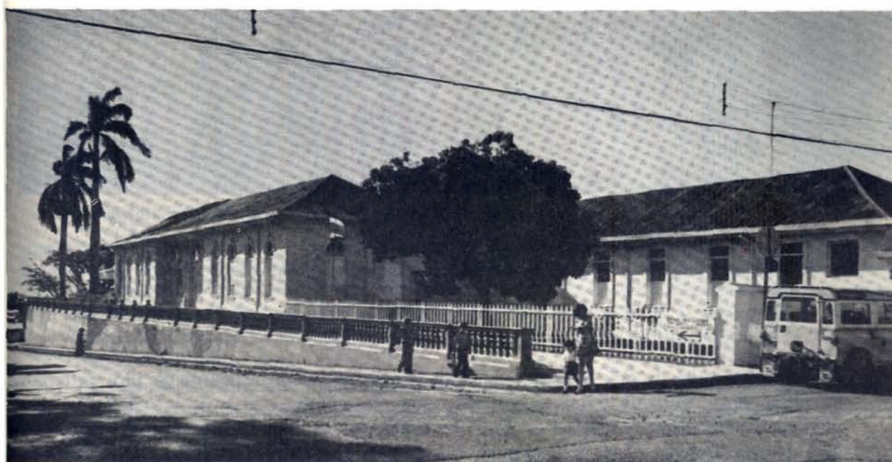
Vista parcial del edificio del Hospital San Rafael de Alajuela.
