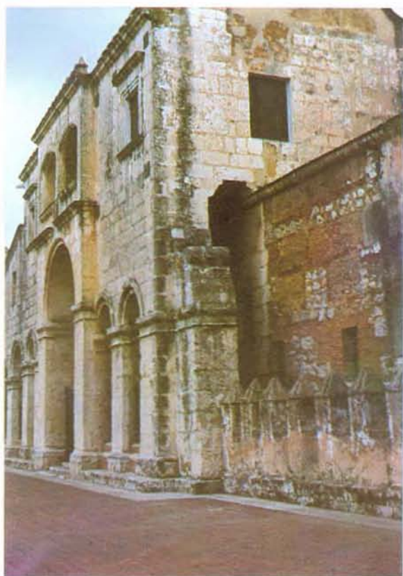
ANTIGUA CATEDRAL DE SANTO DOMINGO. Fachada (Foto del autor)
