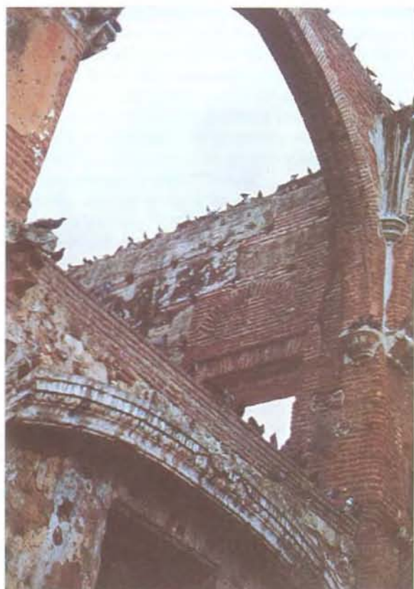
HOSPITAL DE SAN NICOLAS DE BARI: Vista Interior de las ruinas. (Foto del autor)
