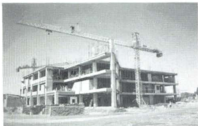
Etapa de construcción del Nuevo Hospital de Alajuela
