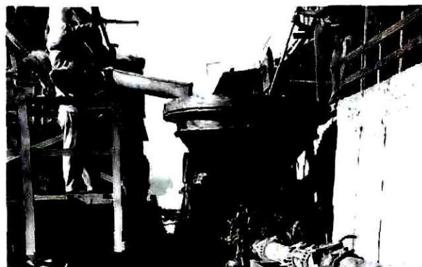
Bomba de Concreto.
