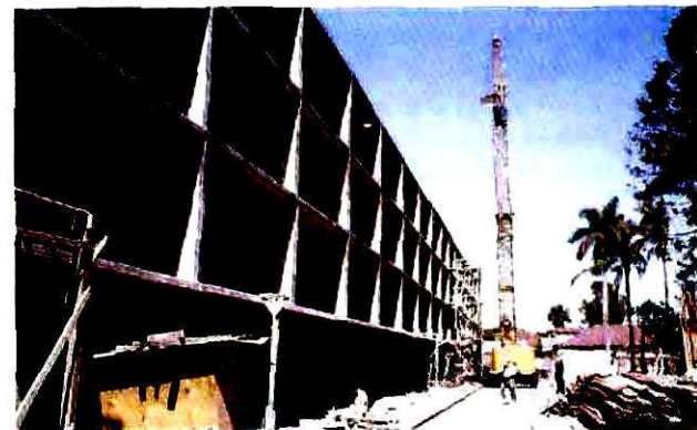
Grúa Liebherr montada en rieles que corría a lo largo de la fachada.
