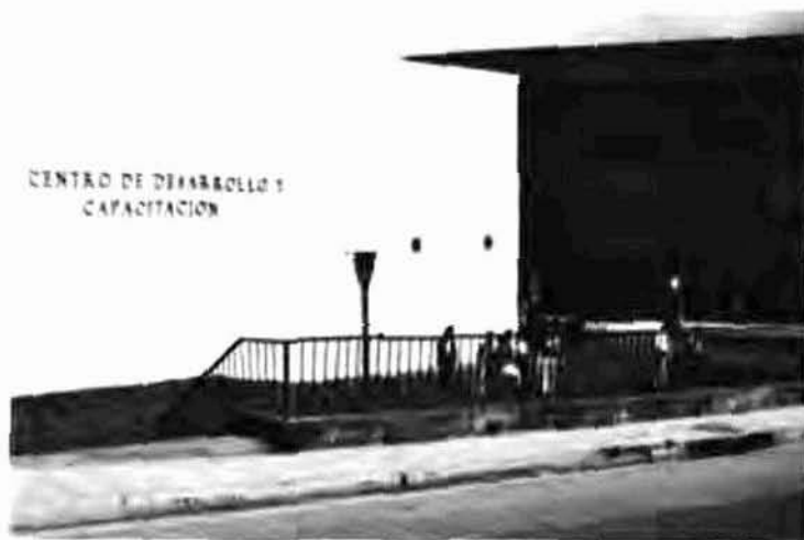
Vista frontal del Edificio que ocupa el Centro de Desarrollo y Capacitación.
