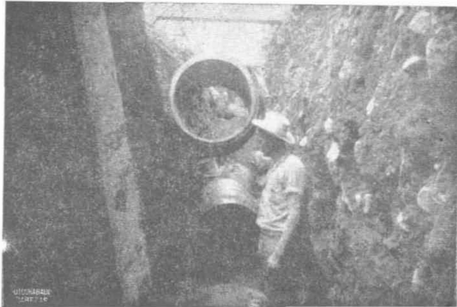
Instalación desagües pluviales.—Ciudadela "Las Américas".—Turrialba.
