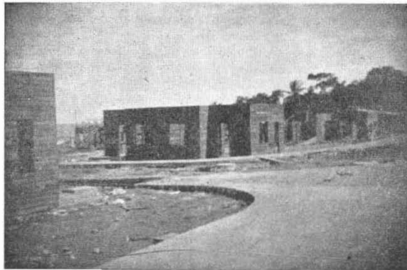
Construcciones en proceso.—LIMÓN.
