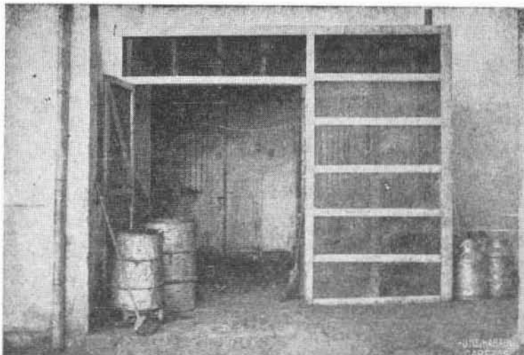
Aspecto del antiguo local de la Carnicería visto por el frente.
