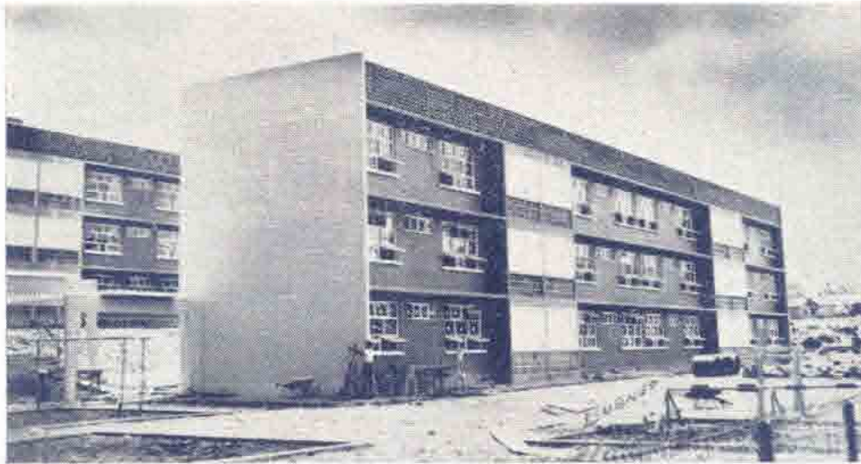
Los edificios se levantaron rápidamente.
