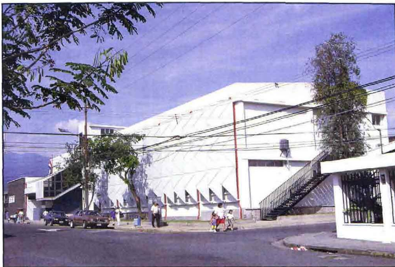
Reconstrucción Clínica Francisco Bolaños (Heredia)
