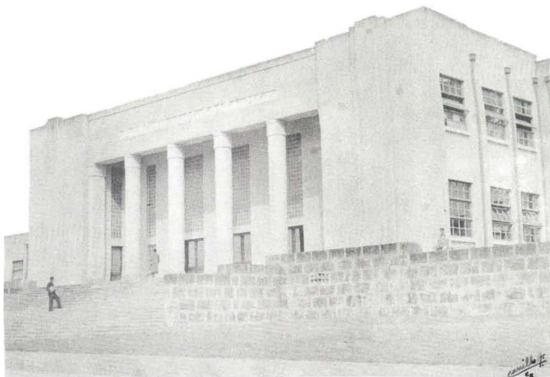
ANTIGUO EDIFICIO DE LA UNIVERSIDAD EN BARRIO GONZALEZ LAHMANN DONDE SE ALOJARON TODAS SUS ESCUELAS Y DEPARTAMENTOS
