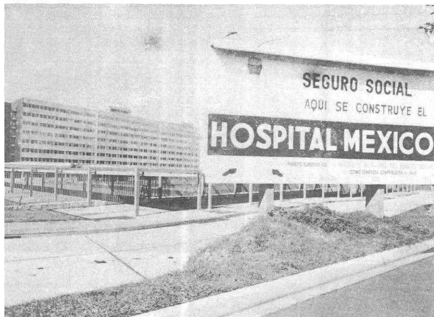
En los sesentas se inició la construcción del Hospital México.
