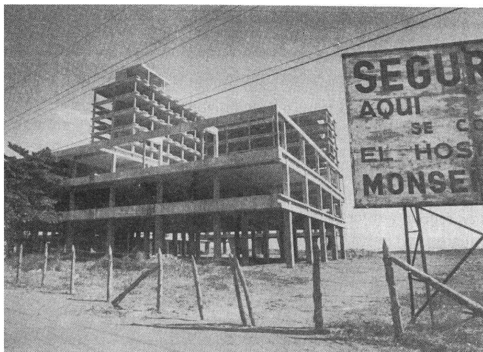
El Hospital Monseñor Sanabria en construcción.
