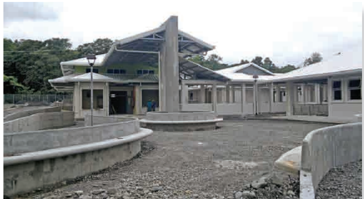
La construcción de los quince módulos que conformarán el nuevo Centro de Atención Integral en Salud (CAIS) de Siquirres avanza en forma satisfactoria. La nueva sede tendrá un área de construcción de 8.500 metros cuadrados, un costo cercano a los ₡11 900 millones y su diseño cumplirá con todos los estándares de construcción y de seguridad nacional e internacional, así con las disposiciones de la Ley 7.600 para garantizar el acceso a personas con necesidades especiales
