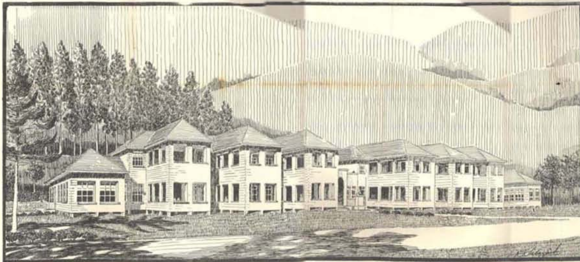
DEPARTAMENTO PARA NIÑOS (EN CONSTRUCCION)
