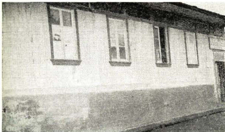
Viejo edificio en que estaban instalados los servicios en Juan Viñas.
