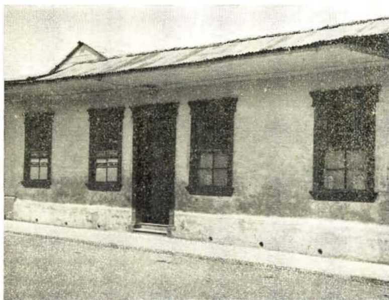
Fachada del Edificio de la Sucursal de San Ramón. Obsérvese las malas condiciones en que se encuentra.
