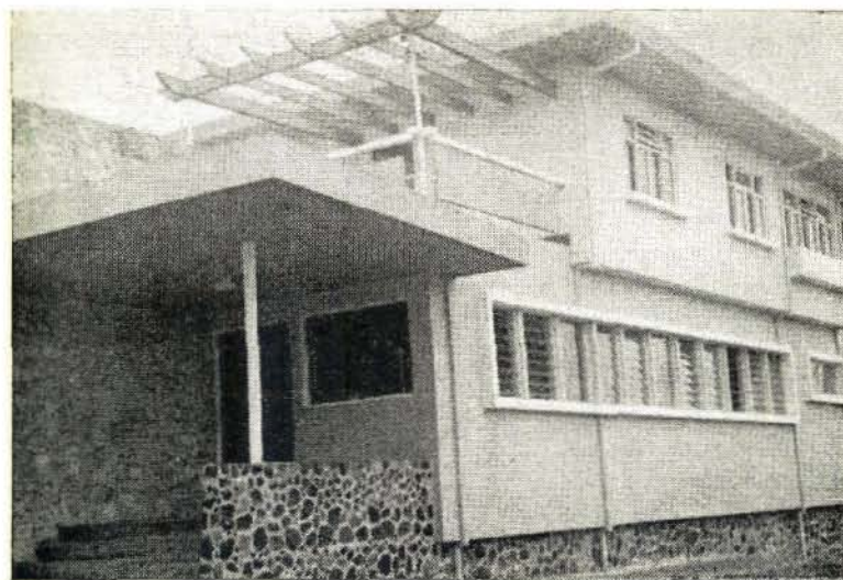
Edificio nuevo inaugurado en el mismo lugar con el cual la Caja demuestra su constante afán por brindar mejores servicios a los trabajadores.
