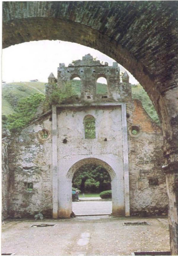
INTERIOR DE LAS RUINAS DE UJARRAS
