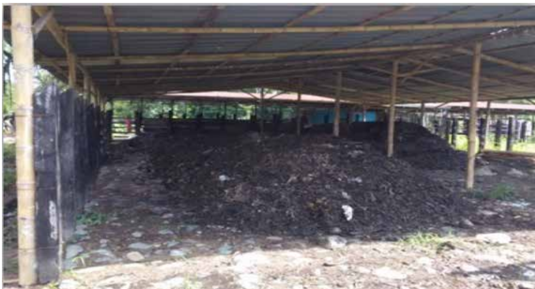
Figura 13. Ejemplo de Centro para el tratamiento de residuos orgánicos
